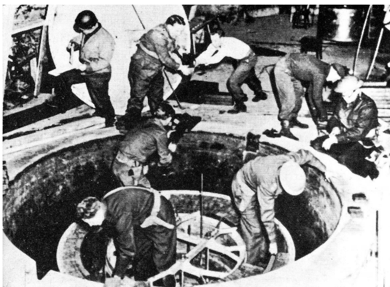
Демонтаж немецкого экспериментального ядерного устройства английскими специалистами в Хайгерлох (50 км на юго-запад от Штутгарта), апрель 1945 г.
